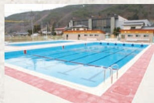
明南小学校・明科中学校共用プールが完成
