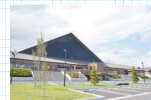
穂高会館(改修)
