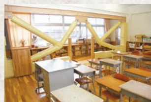
豊科南小学校大規模改造工事が完了
