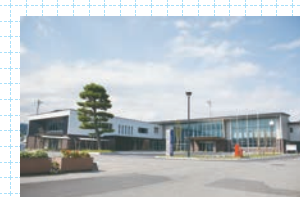
明科支所・公民館
