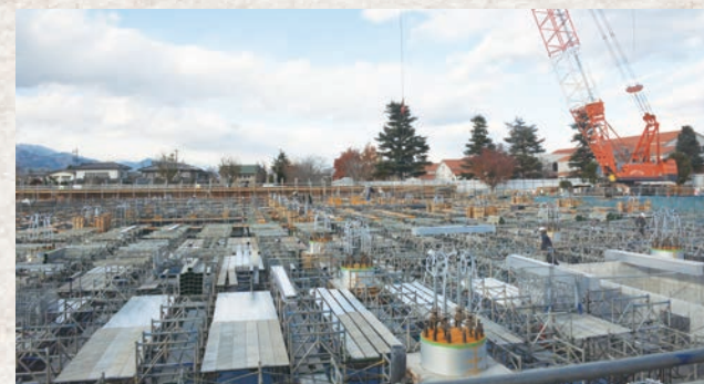
新本庁舎建設が始まる
