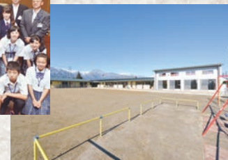
北穂高保育園改築工事が完了
