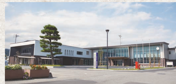
明科支所・公民館が完成
