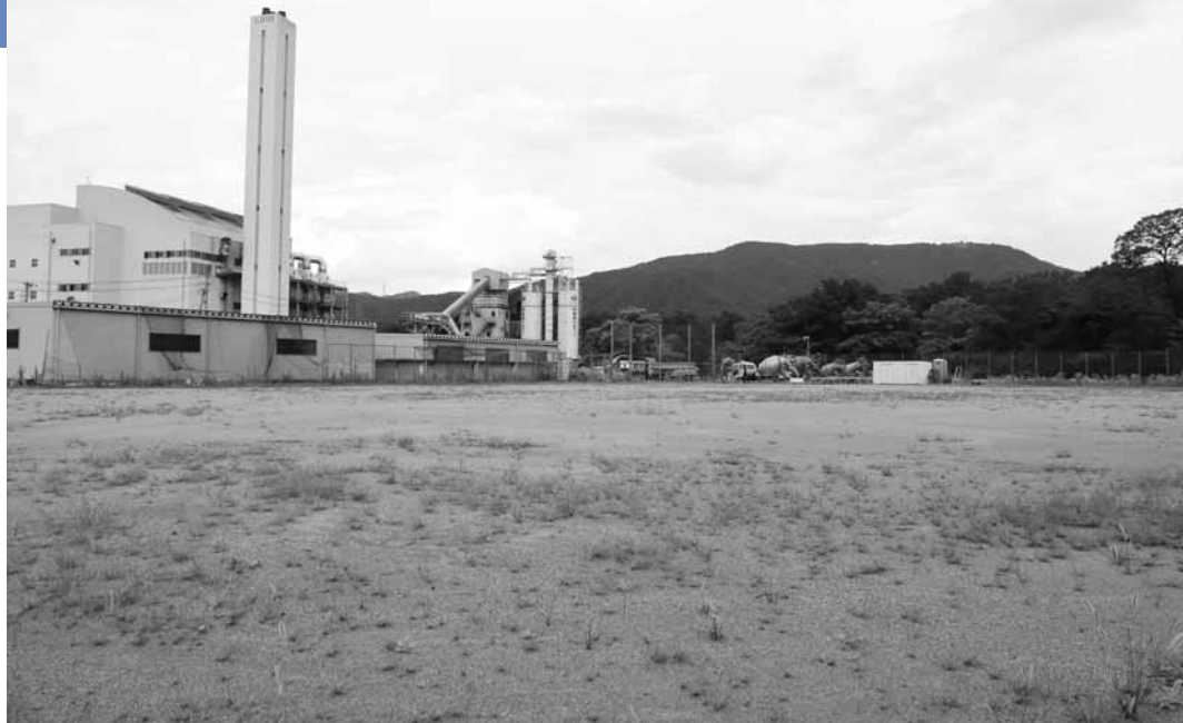
建設予定地（写真手前のグラウンド）
