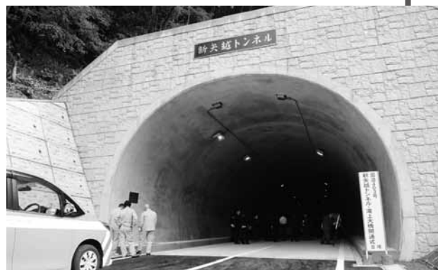
開通した新矢越トンネル
