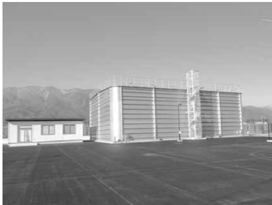
耐震化工事が行われた上長尾配水池
