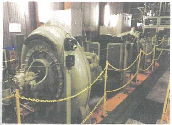
▲宮城第一水力発電所
