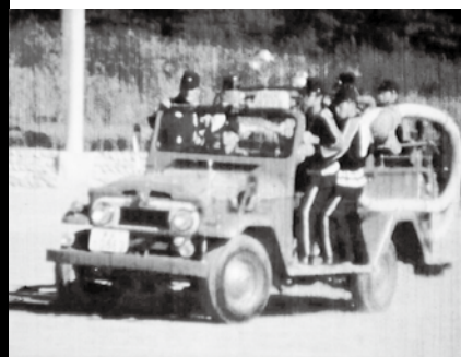
昭和 50 年頃 明科 消防ポンプ操法
