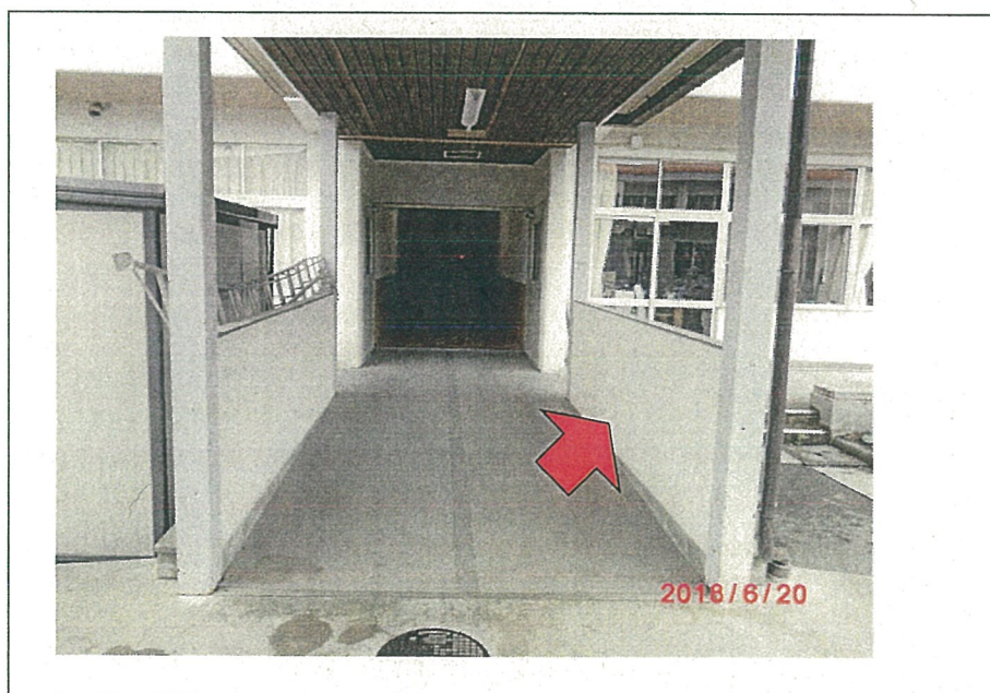
コンクリートブロック塀
