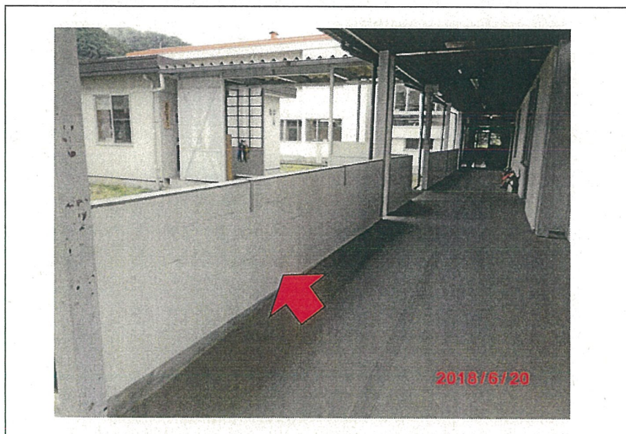
コンクリートブロック塀
