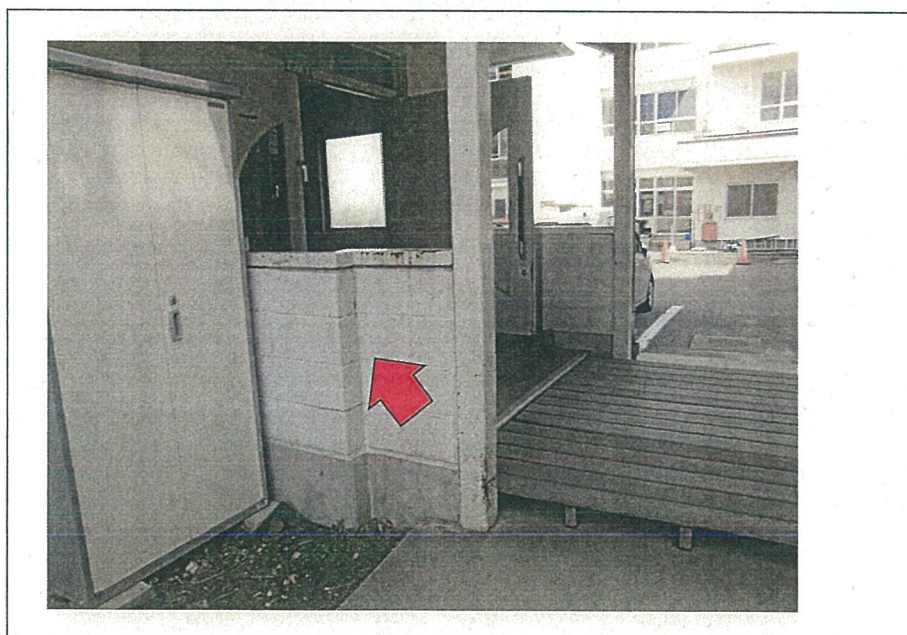
コンクリートブロック塀
