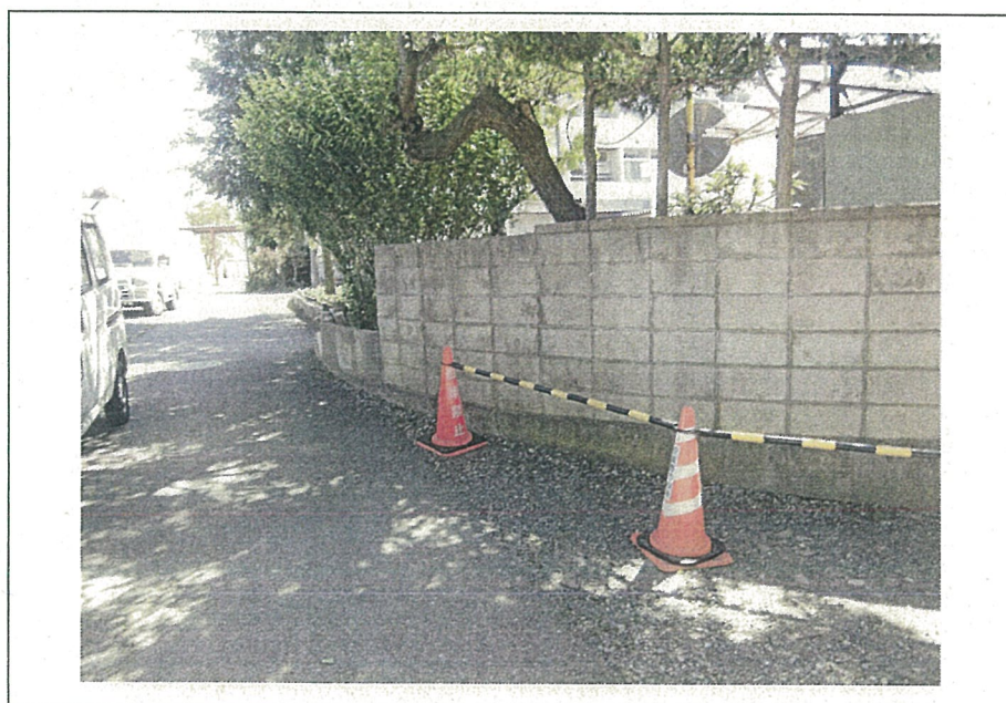
コンクリートブロック塀
