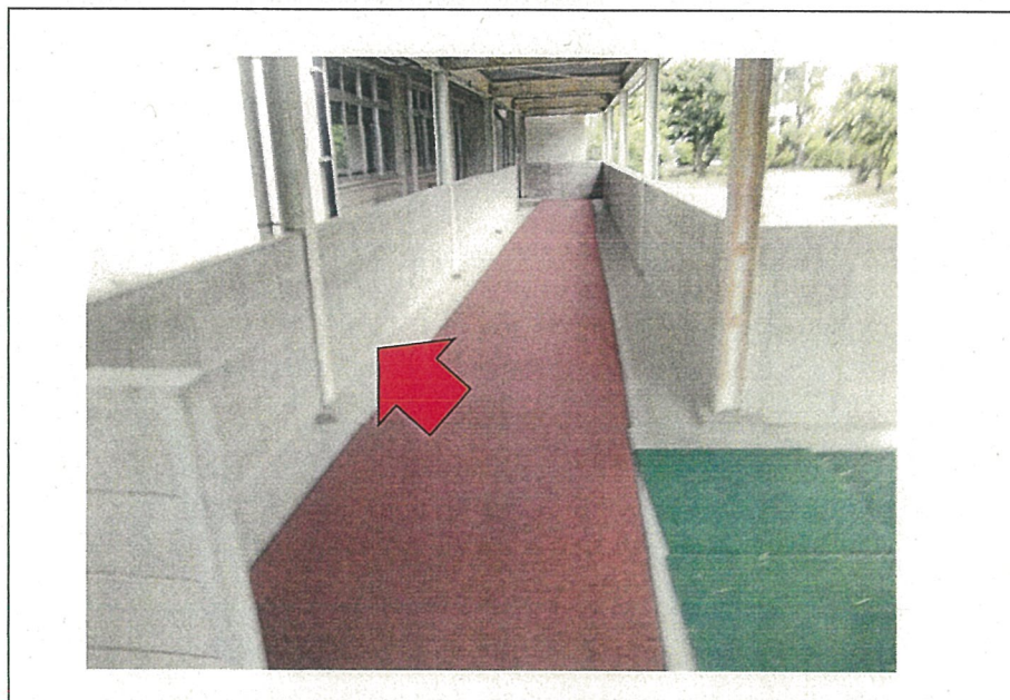
コンクリートブロック塀（渡り廊下）
