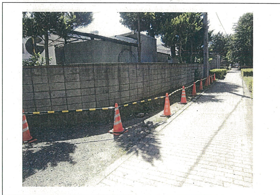
コンクリートブロック塀
