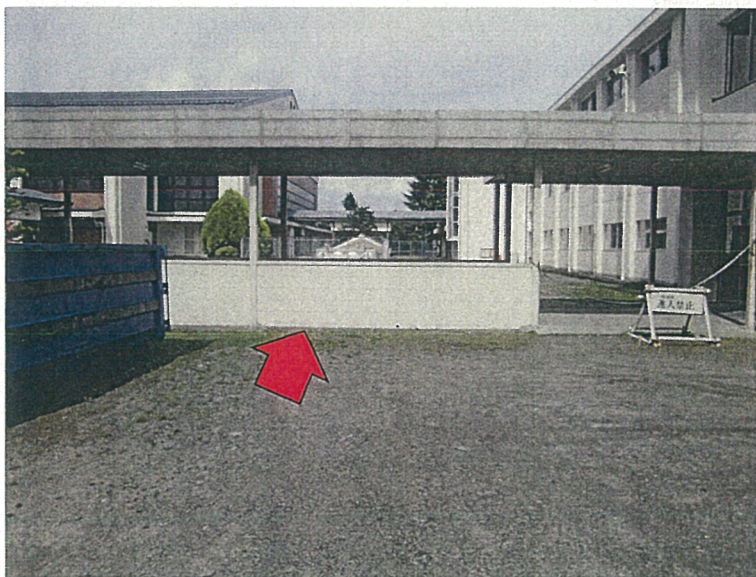
コンクリートブロック塀
