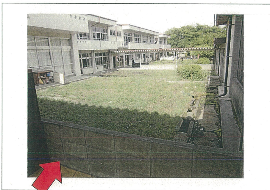
ブロックコンクリート塀（高学年棟前渡り廊下）
