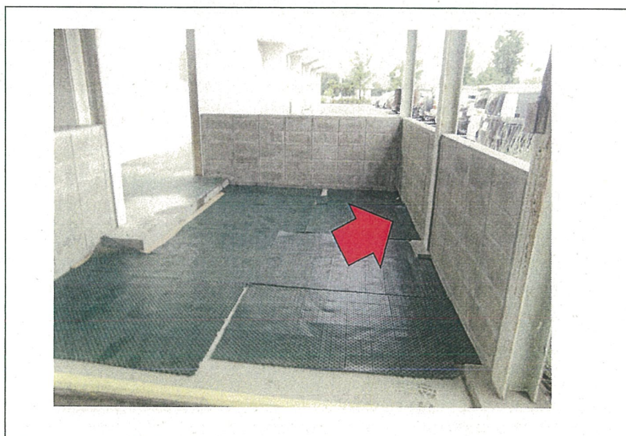
コンクリートブロック塀（渡り廊下）
