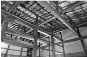
屋根裏小屋組み
