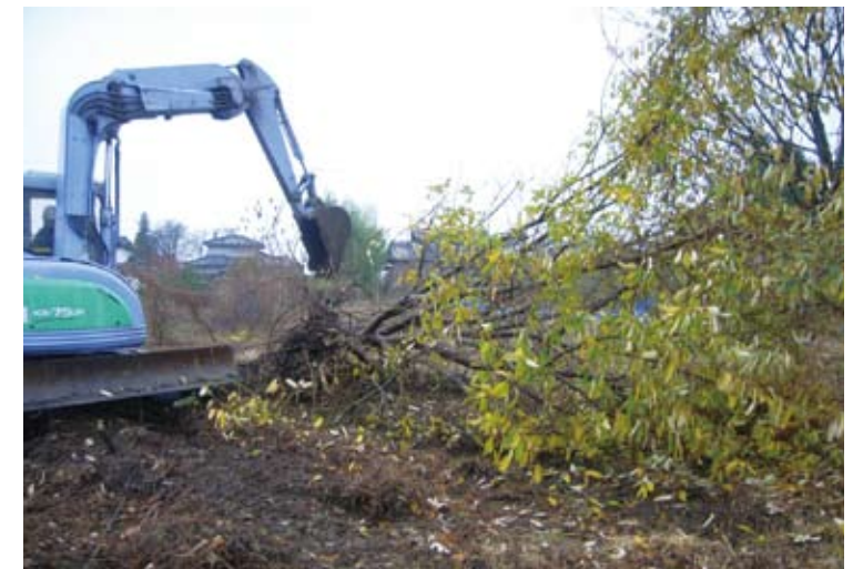
抜根作業の様子
