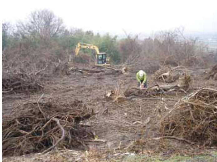
切り倒した木の抜根作業の様子
