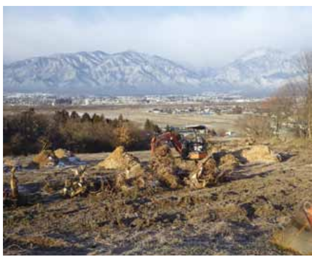
伐採した樹木の片づけの様子
