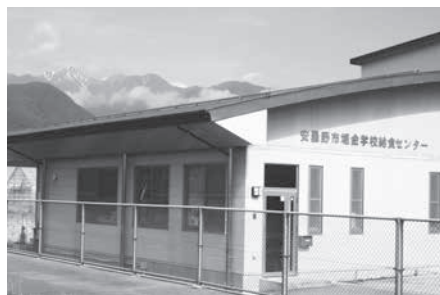
堀金学校給食センター
