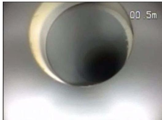
写真 4-2 ■ 洗管後 管内状況
