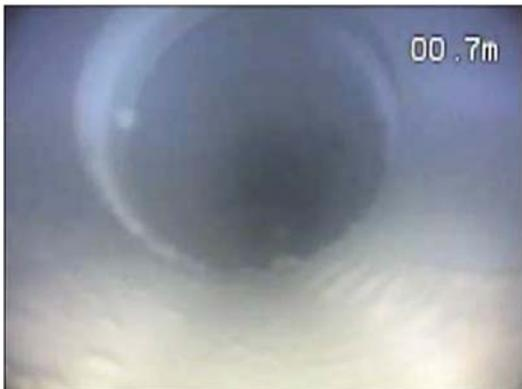
写真 4-1 ■ 洗管前 管内状況
