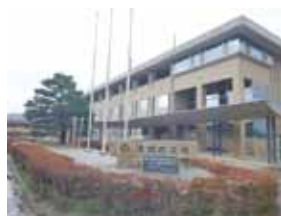
浸水被害を受けた 長野市豊野支所
