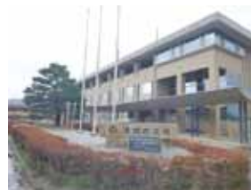
浸水被害を受けた 長野市豊野支所
