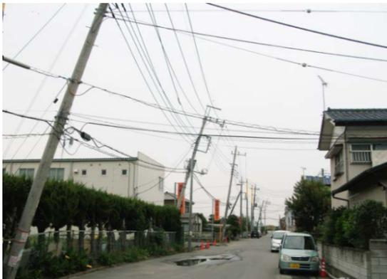
液状化による電柱の倒壊
