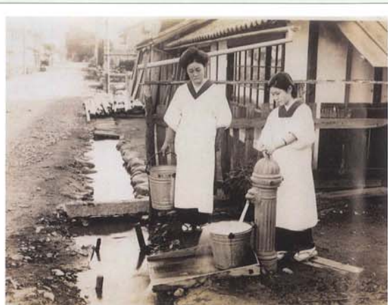
設置直後の共同栓 豊科町成相(現安曇野市) (昭和6か7年)
