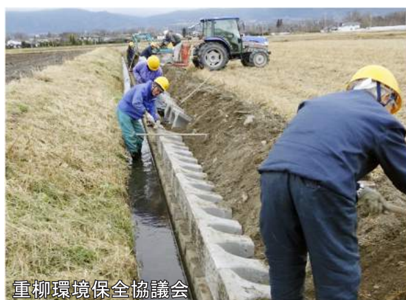
水路法面のブロック積作業(長寿命化活動)
