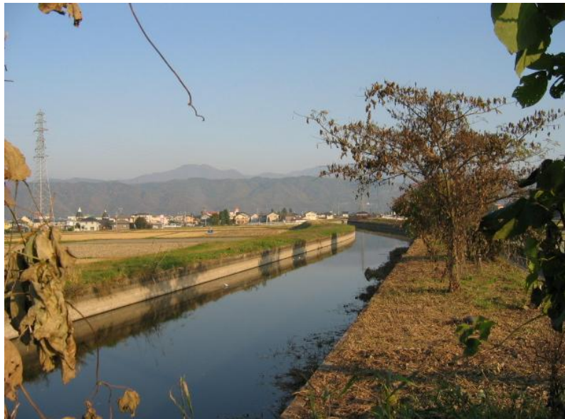
拾ヶ堰(中萱踏切付近から取水口のある東方松本方面を望む)
