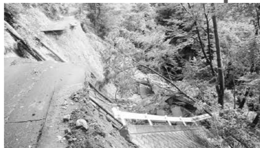
崩落した林道長峰線
