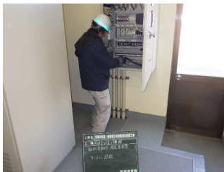
盤据付・結線
