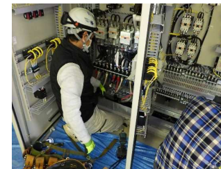
盤据付・結線
