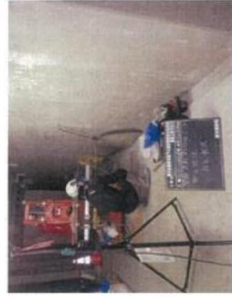
汚泥処理棟耐震工事(削孔状況)
