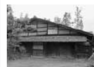
江戸時代後期の木造平屋建ての主屋
