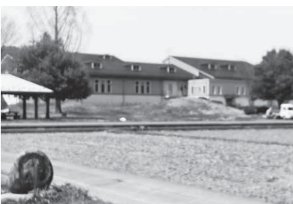
統廃合計画のある明科浄化センター
