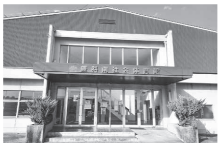
廃止予定の豊科南社会体育館
