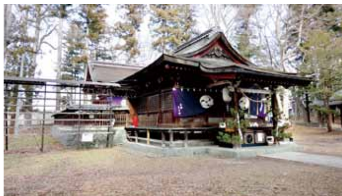
第11-1図 筑摩八幡宮拜殿（松本市筑摩）
