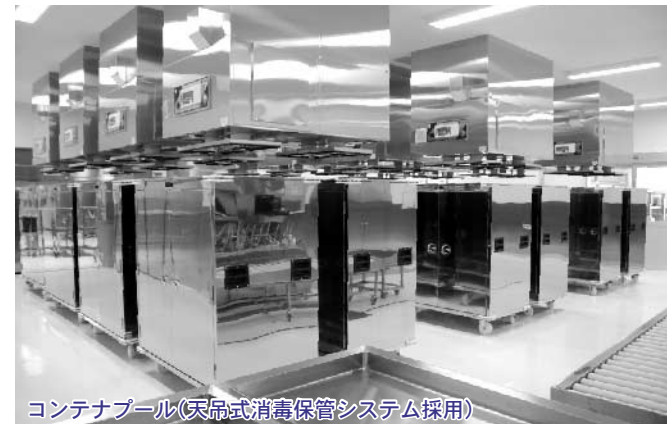
コンテナプール(天吊式消毒保管システム採用)
