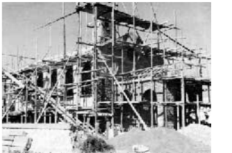
建設中の美術館本館
