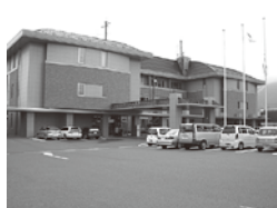
堀金総合支所
