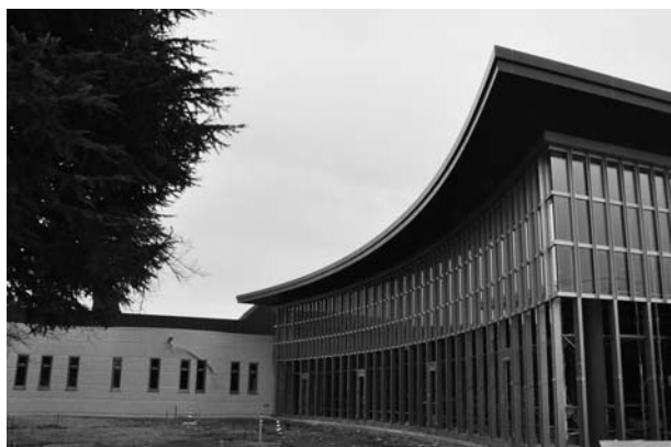
完成間近のエントランスホール外観
