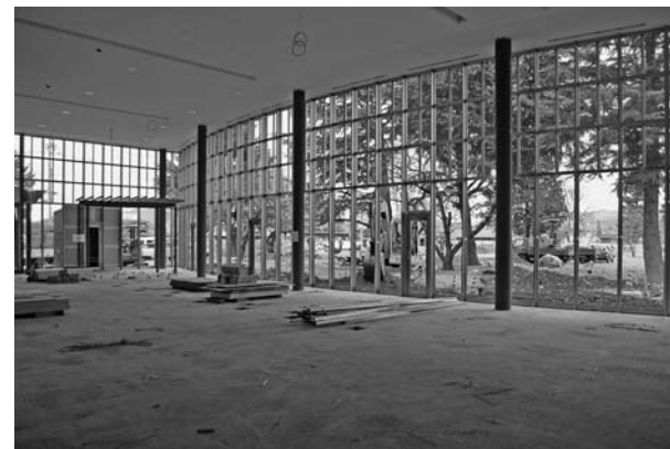
完成間近のエントランスホール内
