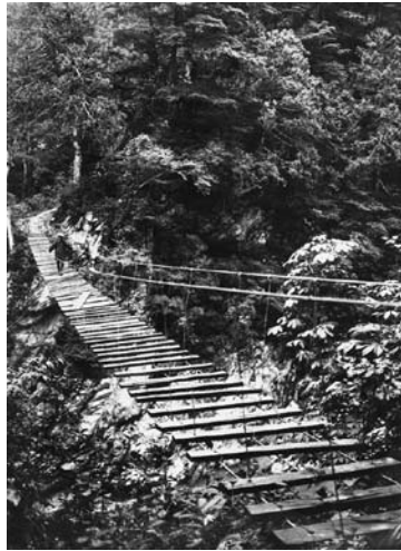
河野齡蔵 「黒部川の吊り橋」 (1920年7月撮影)
