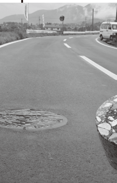
△細かく砕かれたガラスが入っているアスファルト合材で舗装した道路。
