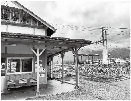
駐輪場の屋根設置を待つ安曇追分駅
