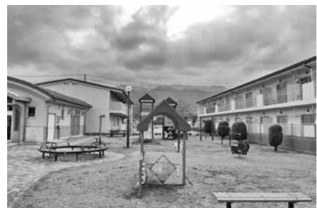
遊具のある中庭から見る市営追分団地
