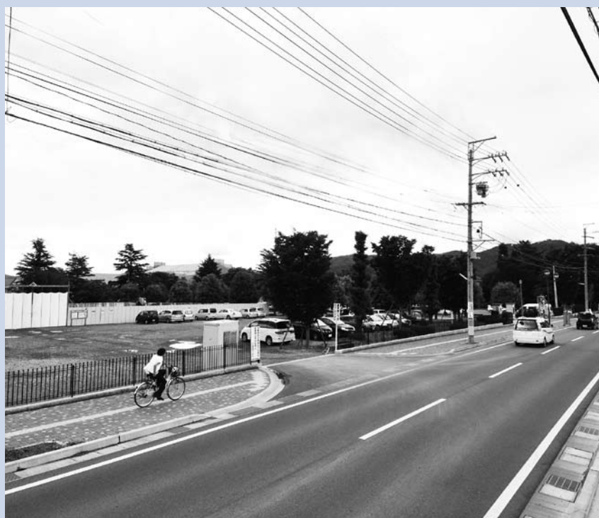
豊科近代美術館周辺。道路の向こう側に見えるのが美術館西側駐車場。さらにその奥には豊科近代美術館と建設中の豊科交流学習センターがある。
