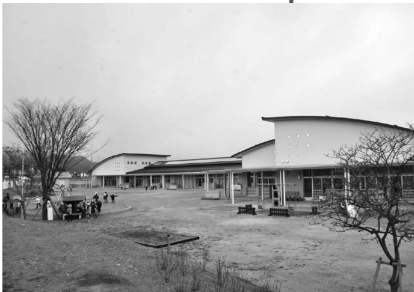
新しくなった園舎。定員も拡大します
