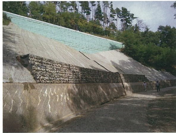
林道白牧線工事完了後
