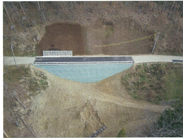
林道長峰線工事完了後
