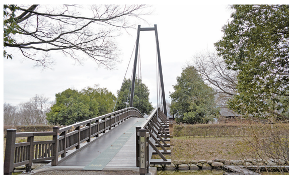
令和5年度に整備したかじか橋に続いて遊具・駐車場を改修
