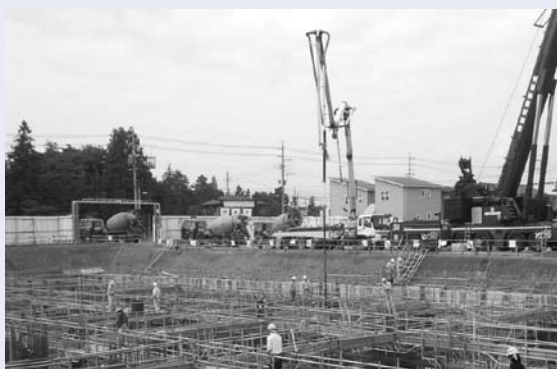
基礎工事の様子（7月5日）
