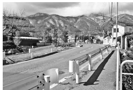
主要地方道田尻の五差路東の歩道整備場所
