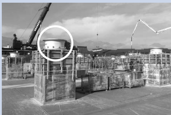
地下駐車場の柱の上に取り付けられた免震装置（白枠部分）（10月29日撮影）
