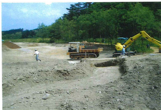
参考：上流側の造成当時の状況
