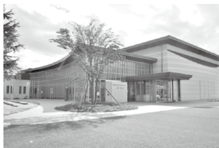
みらいの外観
