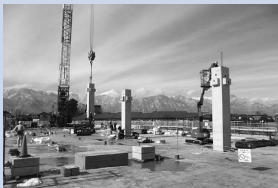
1階部分の柱を設置する様子（1月14日撮影）
