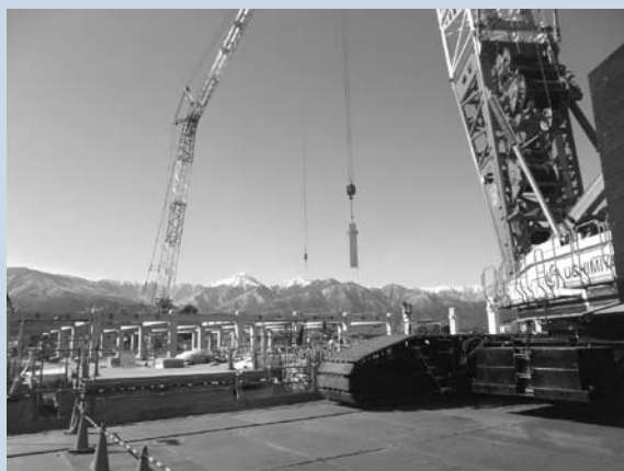
柱と梁の設置工事の様子（2月5日撮影）
