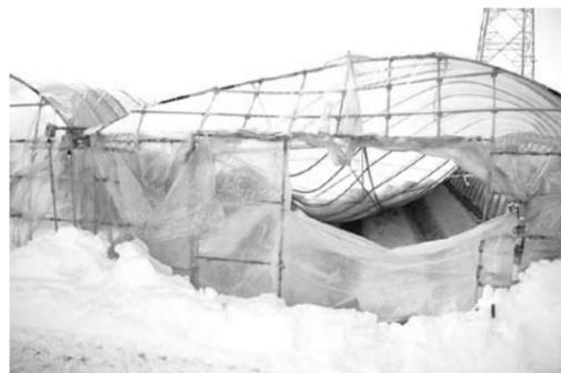
積雪により倒壊した農業用ハウス（堀金烏川）
