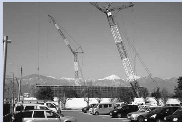
2階部分の柱まで工事が進んだ様子（4月9日撮影）
