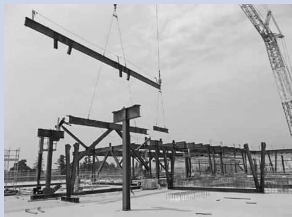
4階部分工事の様子（6月4日撮影）
