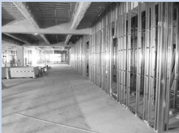
2階内装工事の様子（7月4日撮影）
