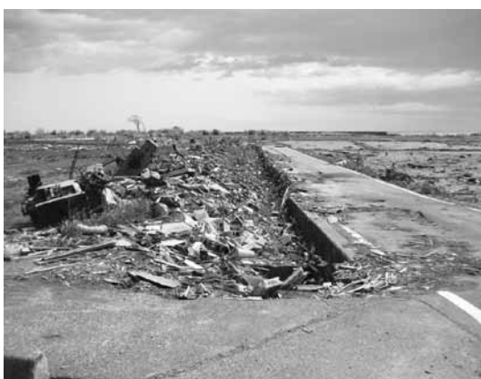
東日本大震災での津波による被害（福島県南相馬市）
