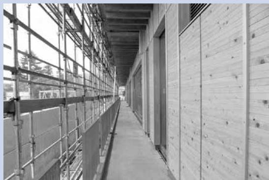
化粧用のヒノキ板で覆われた外壁の様子（8月6日撮影）
