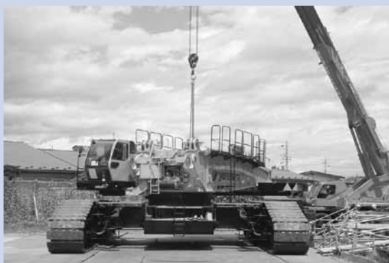
クレーンの解体作業の様子（8月5日撮影）
