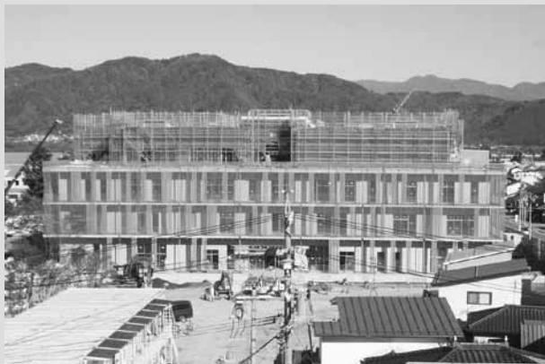
4階部分以外足場が外された本庁舎（11月4日撮影）
