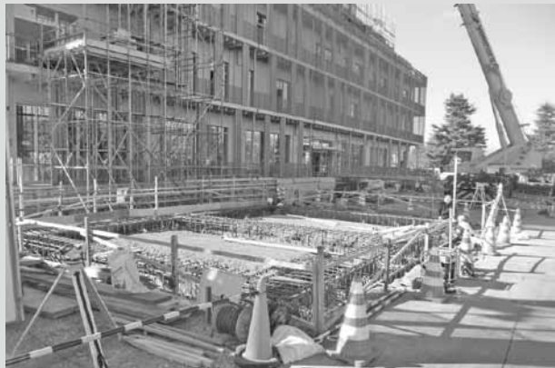
外構工事の様子（11月4日撮影）
