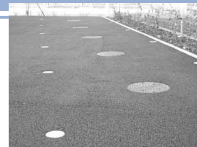
マンホールトイレ
